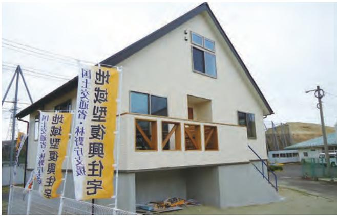
木造軸組蔵構法で耐震性を確保・七ヶ浜町
